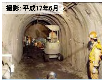
撮影：平成17年6月 100m予備ステージ貫通状況
